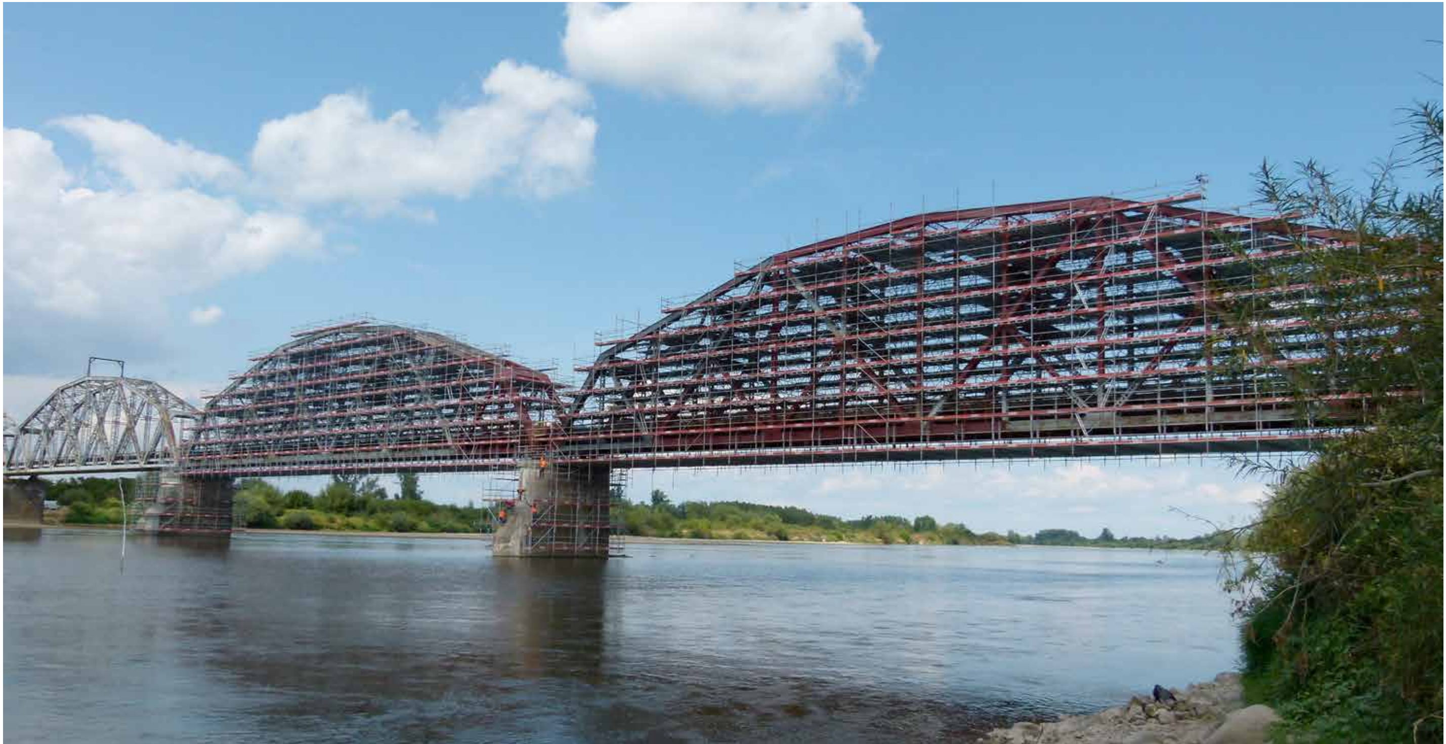
„Zabezpieczenie antykorozyjne mostu kolejowego przez Wisłę w Sandomierzu” Fot. Zdzisław Galas (Kielce). Zdjęcie zgłoszone do Konkursu.
